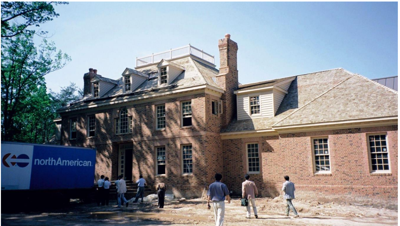
工事中の建物
