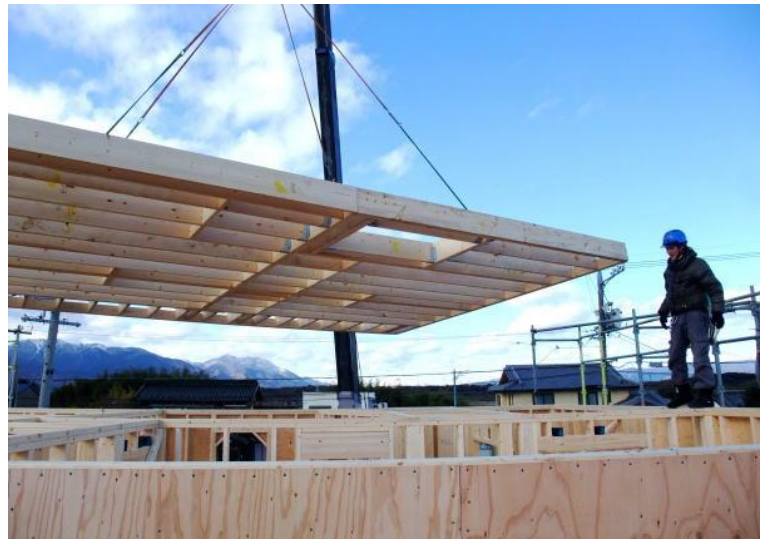
工場直施工のフルパネル組立（高精度）
